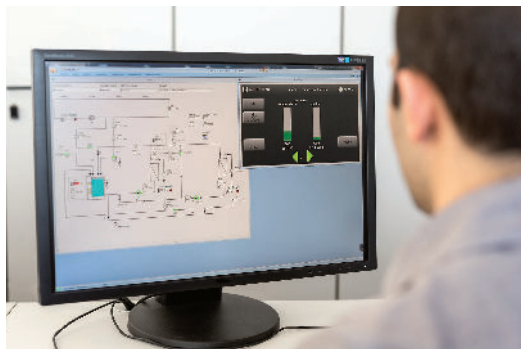
Traitement d'eau avec surveillance à distance
