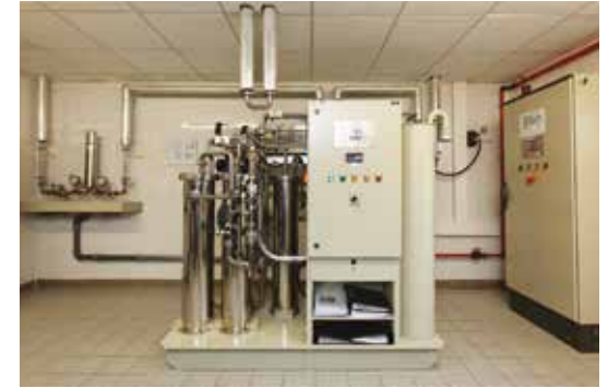
Installation pour traitement d'eau
