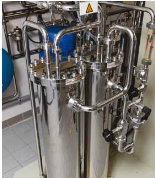
Système de traitement d'eau
